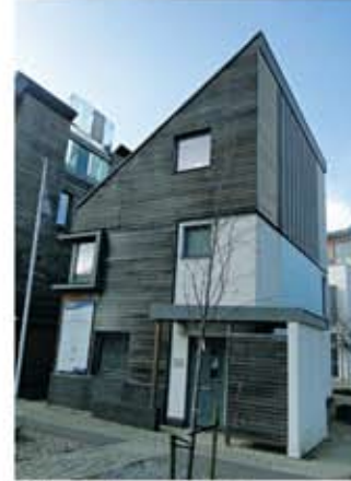
Osborne-arka cephe, giriş kapısının sağındaki ahşap panel ısı kazanını saklıyor.
