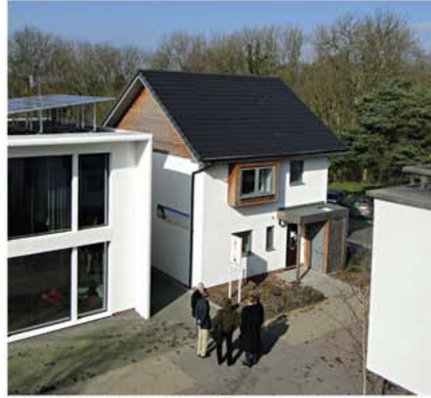
Yenilenebilir Ev, Giriş kısmının sağındaki ahşap panelli bölüm, havadan-suya ısı pompasını barındırıyor.
