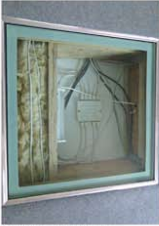
Yapı strüktürü-tesisat ilişkisi
