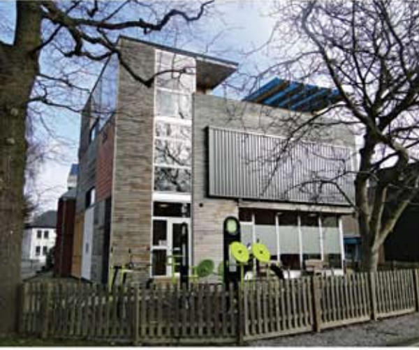
Yapı, önündeki fitness parkıyla bütünlük içinde.
