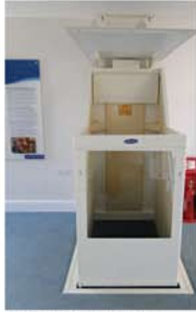
Yapı içine ileride konacak ev asansörü boşluğu hazırlanmış.
