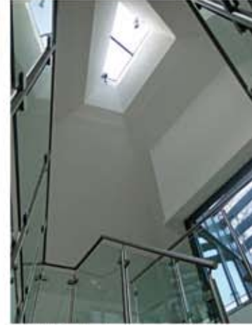
Çatıdaki havalandırma penceresi
