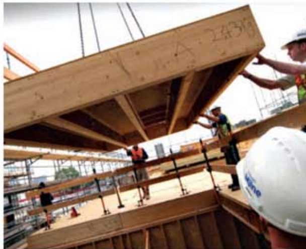
Bina blokları bitmiş halde gelip monte ediliyor.
