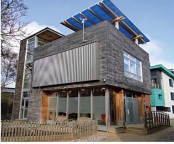
Yan cephe, tepede güneş panelleri aynı zamanda çatı pergolası.
