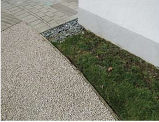
5. Yüzeysel suyun geri dönüşümü ve gri su olarak tekrar kullanımı çok önemli. Bunun için kaldırım döşemeleri harçsız, sert peyzaj geçişin detaylarla projelendiriliyor.
