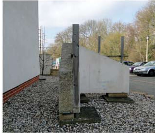
Yapının kesiti, keten-çimento karşışmlı izolasyon malzemesi.
